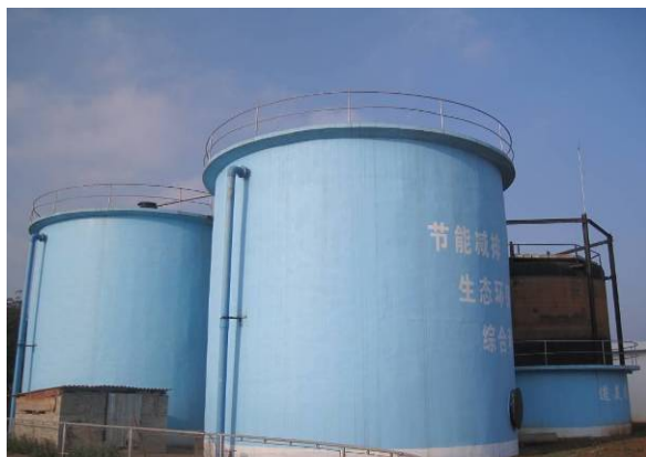
图 1-5a UASB 反应器图
