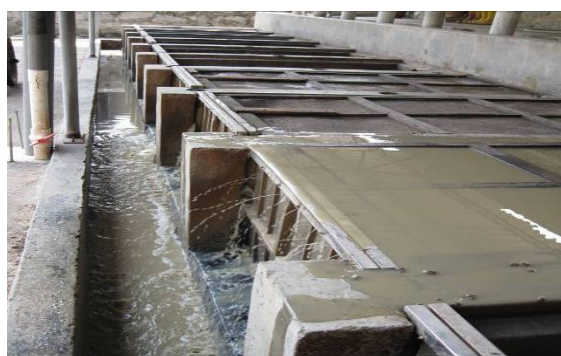
图 1-2 a 自流式滤粪（柜）系统图
