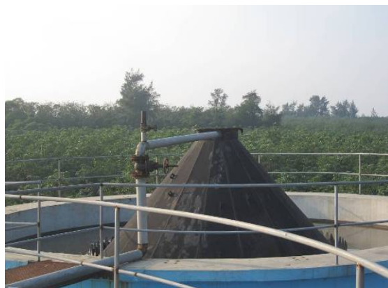
1-5b UASB 反应器三相分离器
